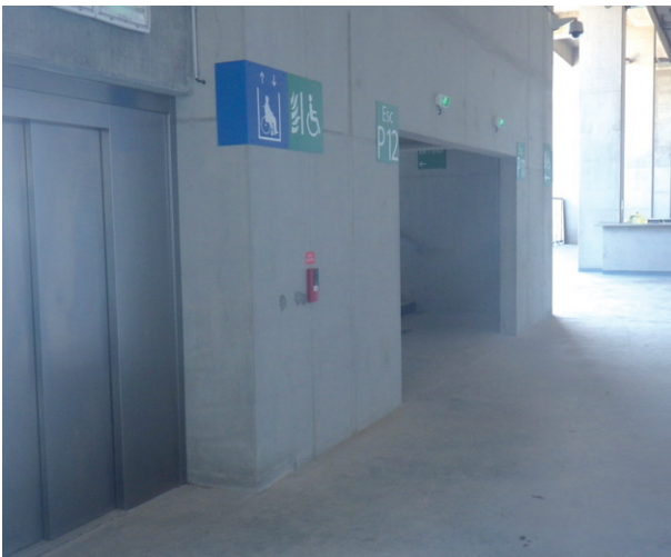
Des ascenseurs, repérés par une signalétique dédiée, permettent la circulation verticale des personnes ayant des difficultés motrices.
