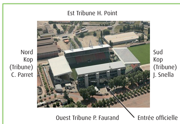
Etat initial du stade Geoffroy Guichard avant travaux
