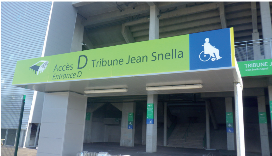
Une entrée avec accès dédié permet aux groupes de handi-supporters de cheminer à l'écart des flux.
